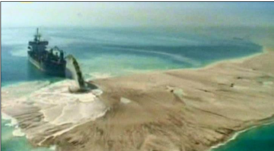
(una de las dragadoras de 8.000 toneladas vaciando arena por el método de "rain-bowing")
